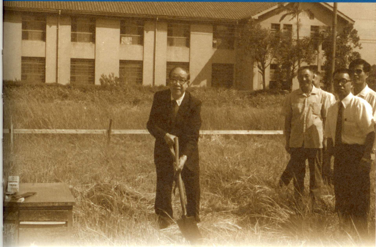
錢思亮(左)手拿鏟子，為本院在臺大的物理所地震組舉行破土典禮。地震組主任蔡義本(右前一)釐清臺灣板塊輪廓，奠定臺灣地震研究基礎，後並籌備成立本院地球所。
